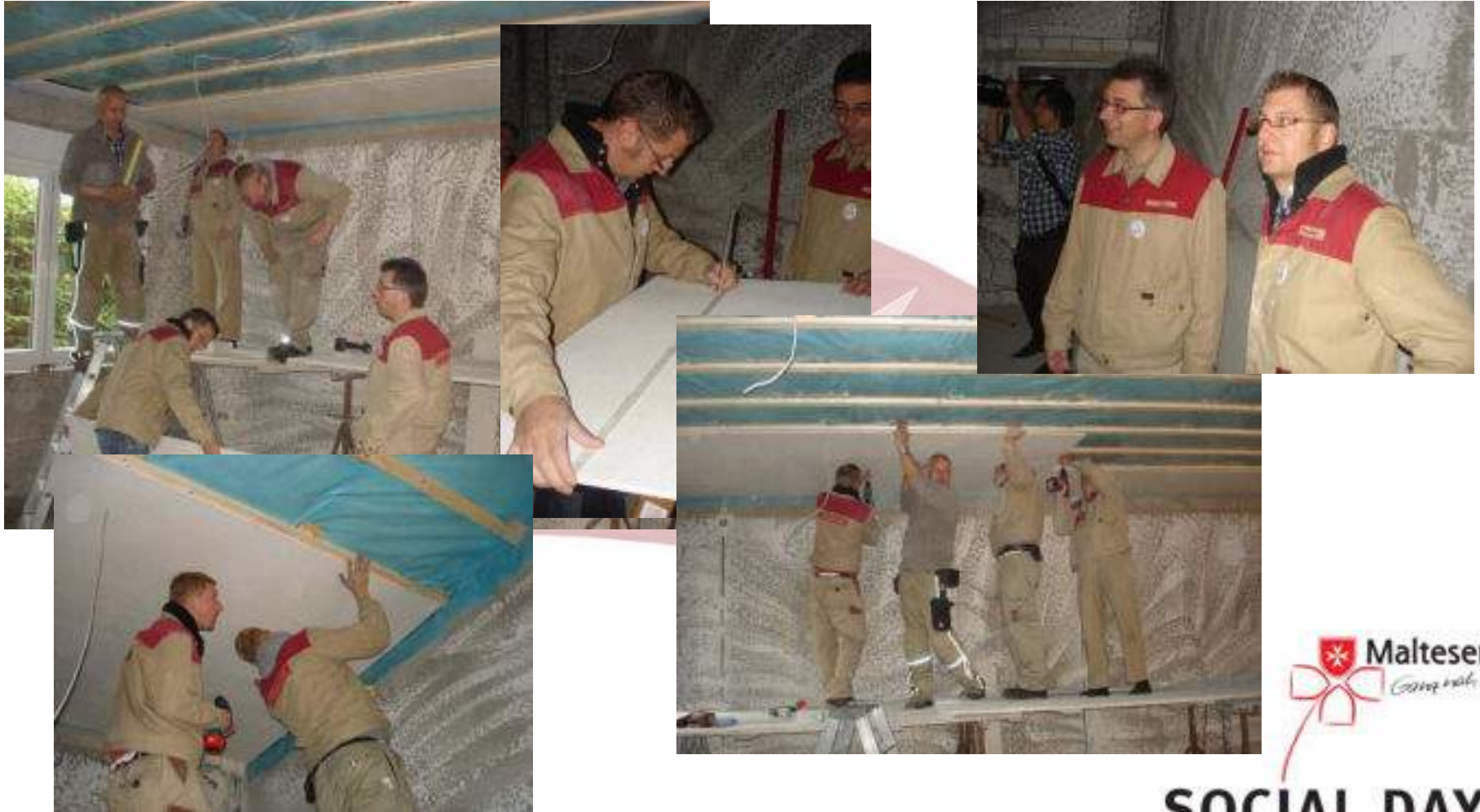
- Fertigstellung der Deckenkonstruktion für einen neuen Gruppenraum der Malteser -
